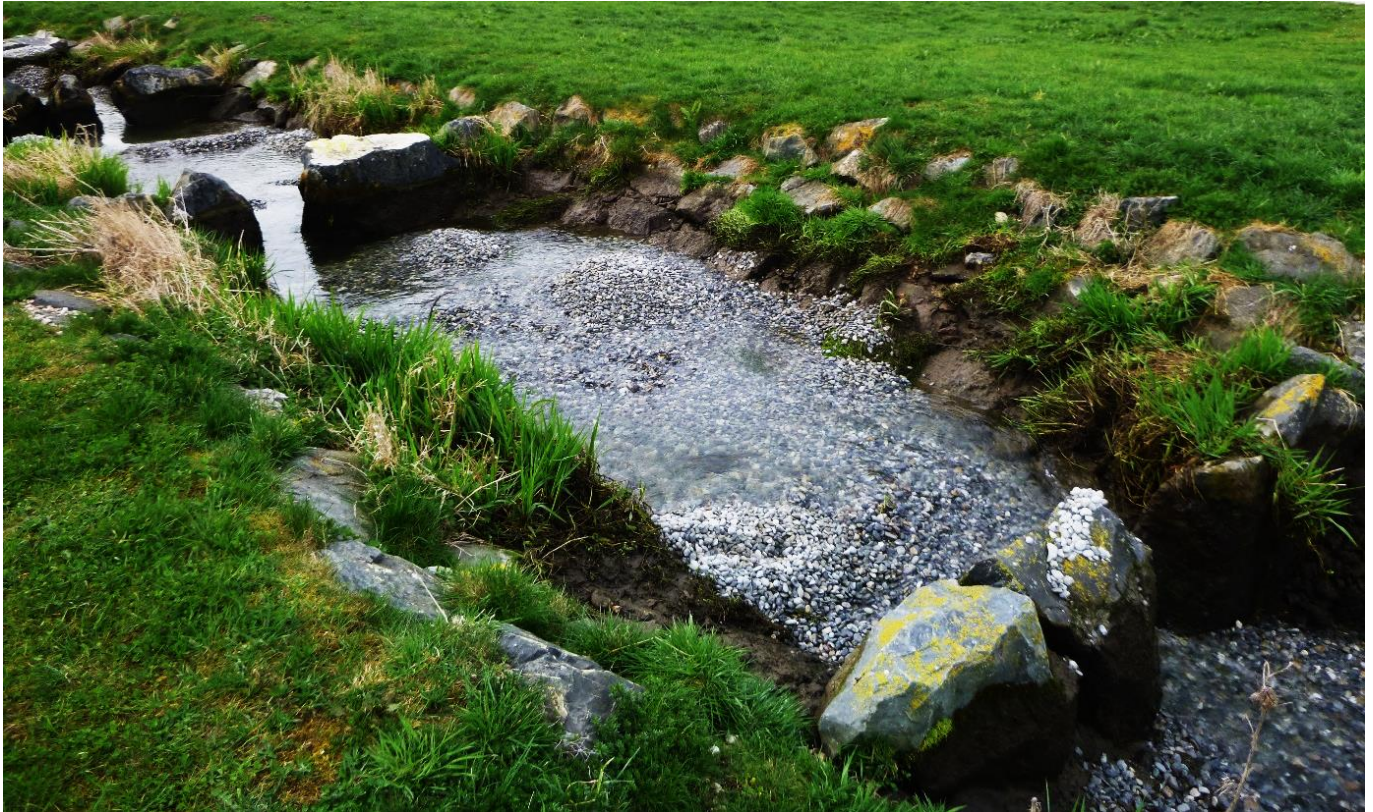
Abbildung 1: Kieseinbringung in die Fischaufstiegsanlage (Quelle: IBF Umwelt)
